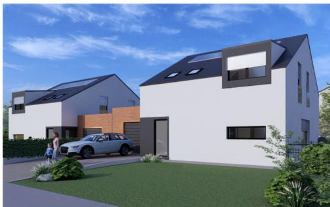
Dům je postavený z keramických tvárníc vyplňených minerální vatou. Strop je železobetonový, vnitřní omítky sádrové. Fasáda je tvořena převážně termoizolační omítkou. Vstupní dveře a HS portál jsou hliníkové, ostatní výplně otvorů jsou plastové. Střešní krytina je keramická pálená na dřevěném krovu. Podlahoviny jsou tvořeny vinylovou podlahou a dlažbou. Součástí jsou i přístupové chodníky a vjezdy k domům.
